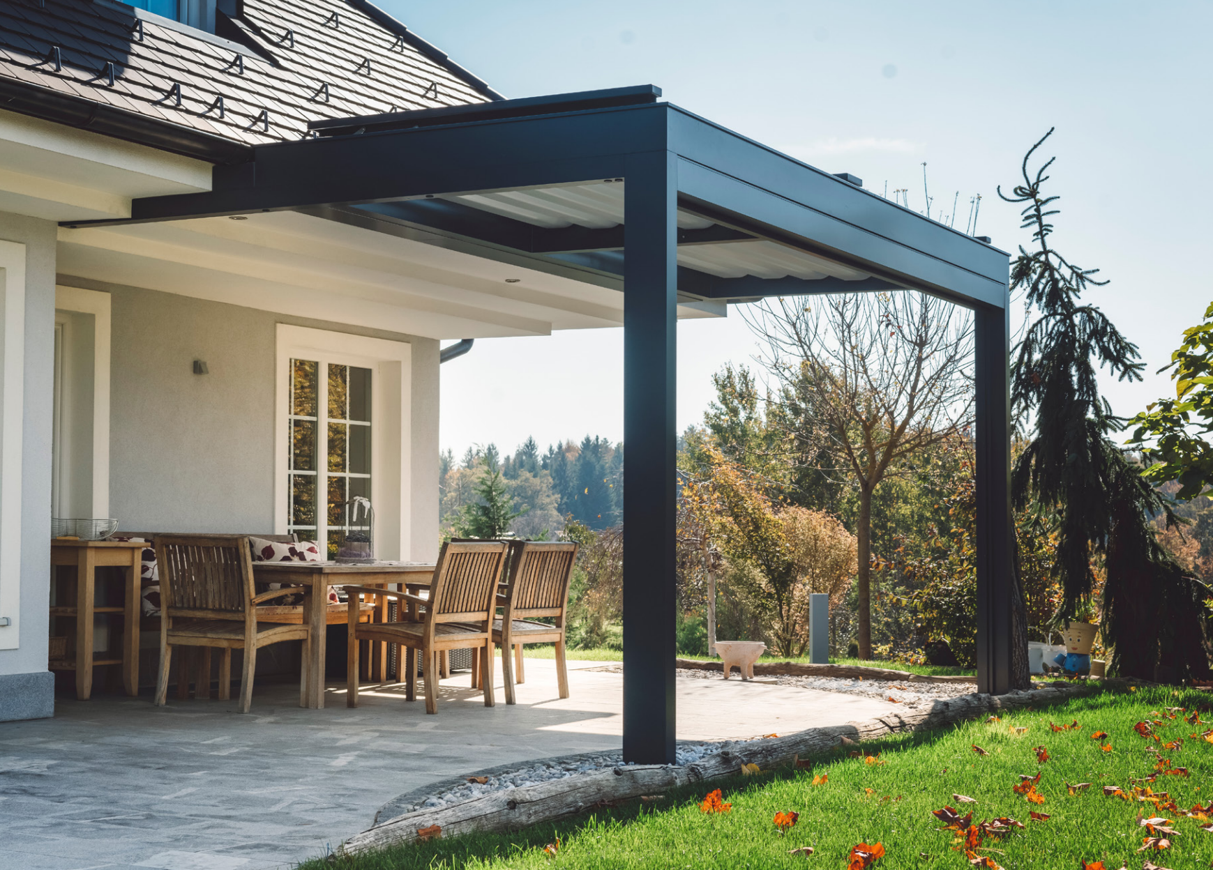
Überdachung auf Schraubfundamenten
